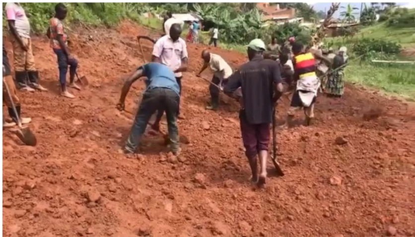
Einebnen des Geländes
