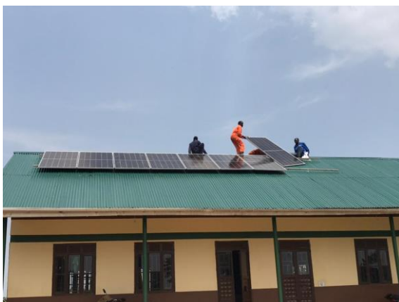
Die Installation der Solarpanels
