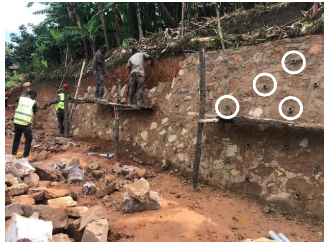
Bau der Stützmauer mit den Abflussrohren
